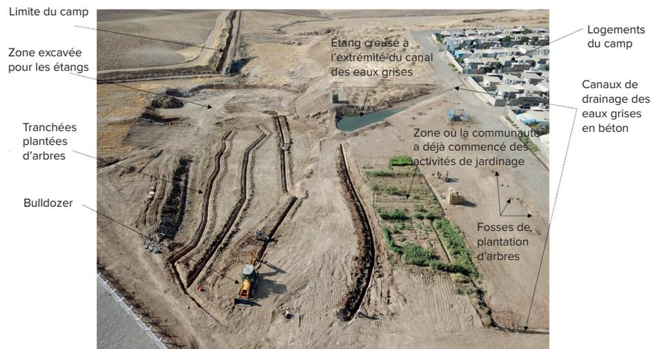
Fig 09. Construction d'une chaîne de gestion des eaux SuDS (système urbain de drainage durable) dans le camp de réfugiés de Gawilan, dans la région du Kurdistan irakien. Charlesworth et al. 2019, p. 3505.
