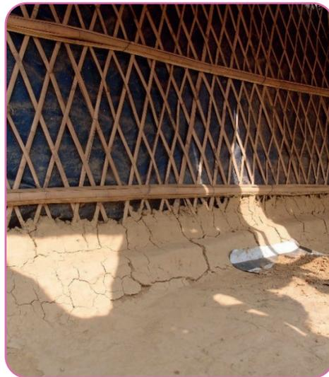
Fig 12. Consolidation d'une structure avec des matériaux réutilisés dans un site de réfugiés. E. Cauderay, CRAterre, 2019.
