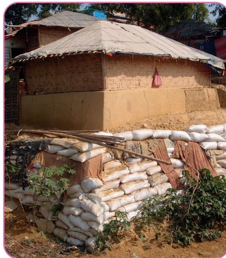
Fig 14. La consolidation des structures dans les sites de réfugiés nécessite parfois un renforcement important. E.Cauderay, CRAterre, 2019.
