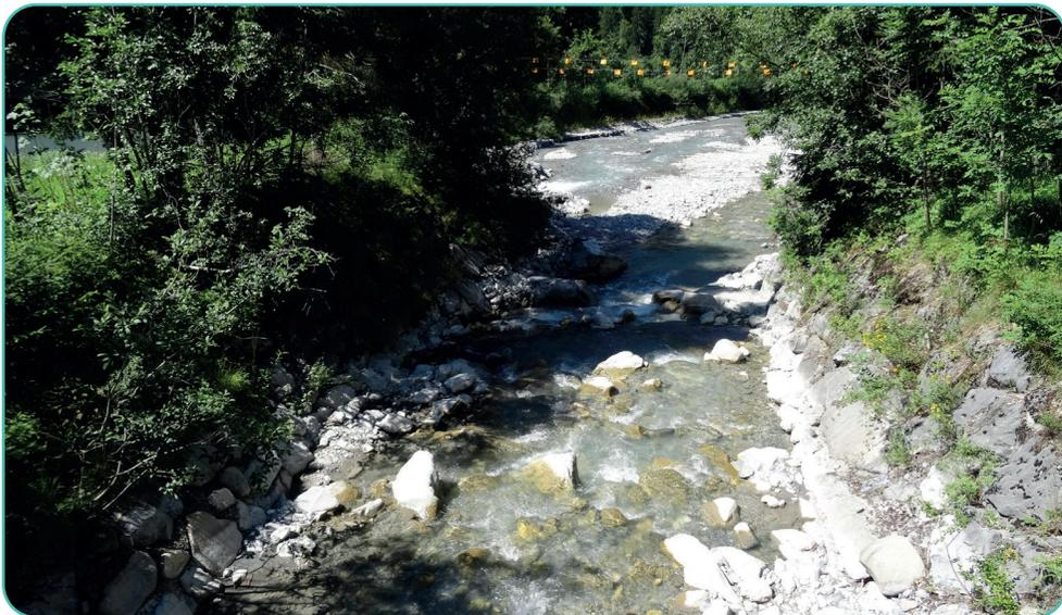
Fig 05. Un enrochement bien conçu peut favoriser la croissance de la végétation arbustive (les grands arbres peuvent provoquer l'effondrement de l'enrochement et doivent être enlevés). Eric Bardou, UNHCR 2022.
